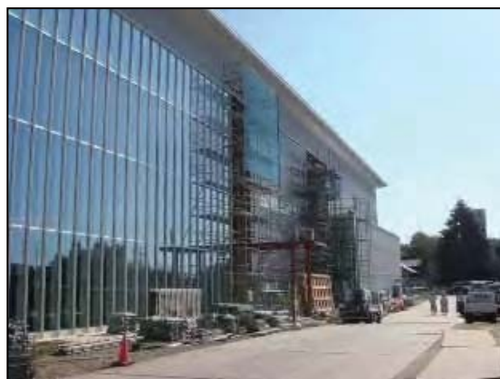
工事現場風景(岡崎市役所 HP より抜粋)
