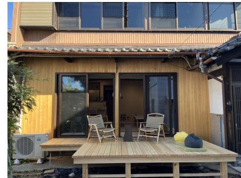
▲改修された空き家の縁側
